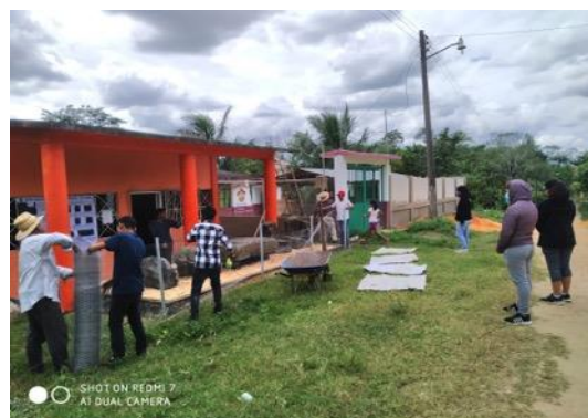
写真 14 科研費による研究の一環でサン・イシドロ村に保管されている先スペイン期石影の保護柵設置(2022年)
