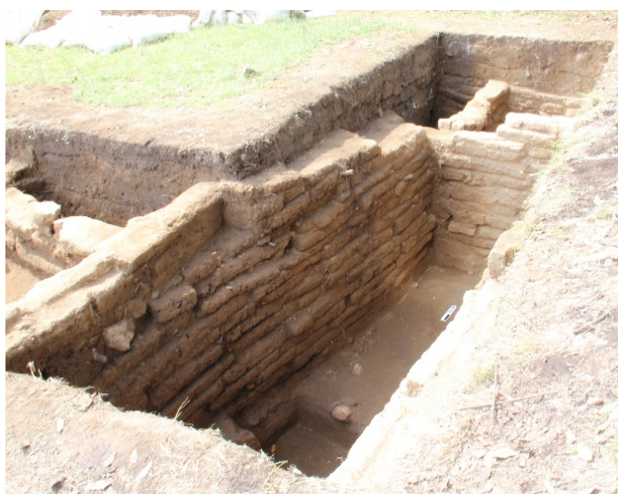
図 10. 部屋状補強土壁工法の一例
