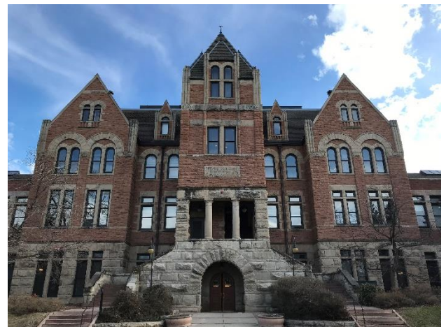
写真1 コロラド大学ボルダー校人類学部棟
