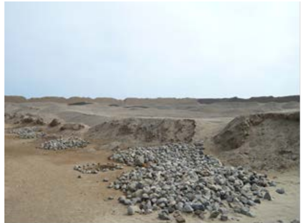
図3 観光ルート外の壁の崩壊
