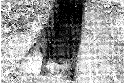
写真11 LH-TU4 半切状況
