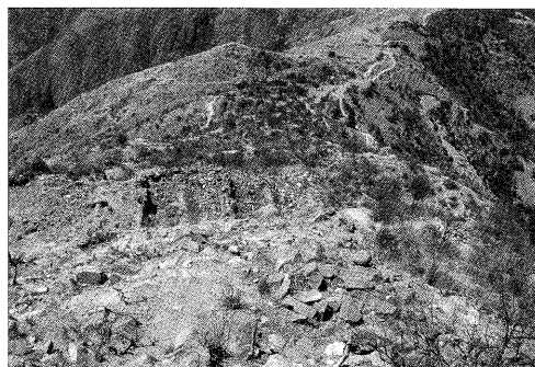
図24 R-E1～R-E4 (北東側より)
